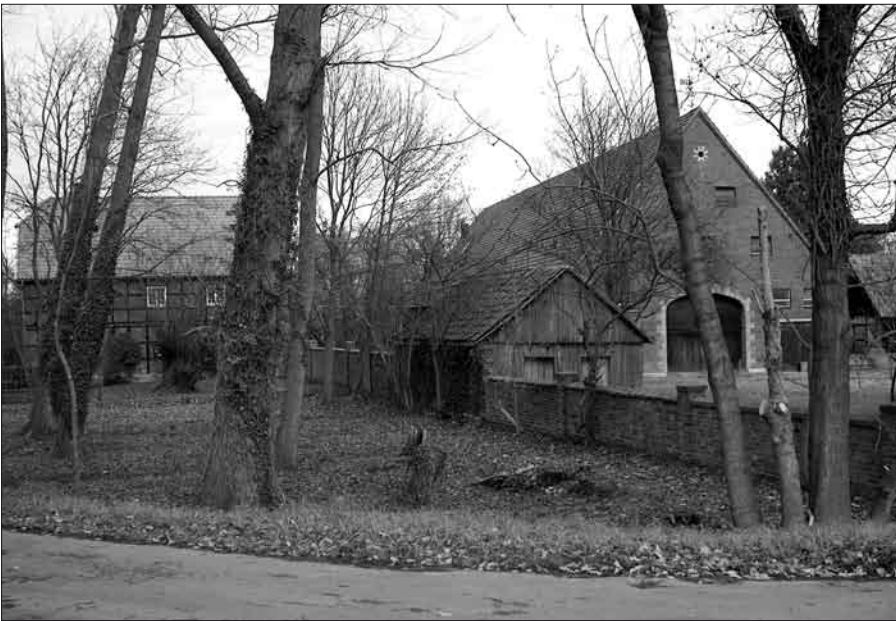
3 Blick auf den Westhoff mit dem Haupthaus (rechts) und dem Fachwerkspeicher von 1830 (links). Foto: Ludwig Sandfort
