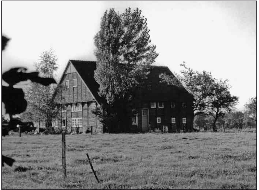
① „Brand's Kotten“, Fachwerkhaus von 1893 auf dem Platz der historischen Ziegelei des Klosters Clarholz. Foto: Johannes Meier
